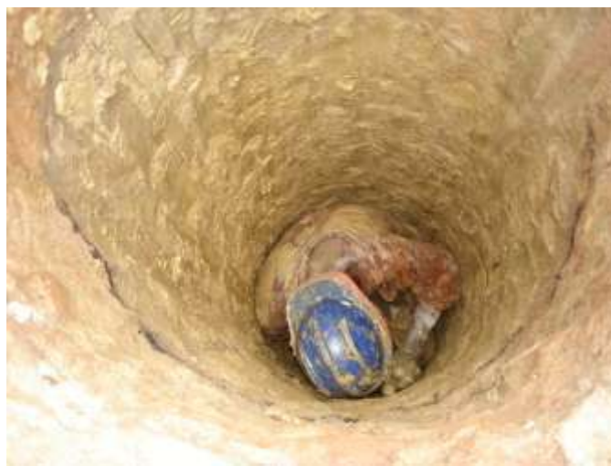
Figura – Execução de fundação em tubulão à céu aberto, em obra de Shopping Center estudado nesta disciplina de “Geotecnia de Fundações e Obras de Terra”
