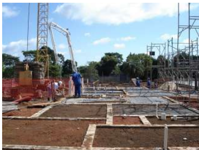
Figura – Fundação direta executada, em sapatas isoladas, com “cintamento” sob paredes da edificação e posterior execução de “contra piso”
