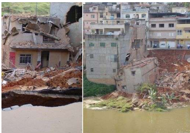
“Dois prédios desabam em mesma rua em Muriaé (MG); não houve vítima”. Tribuna de Minas 01/09/2008
